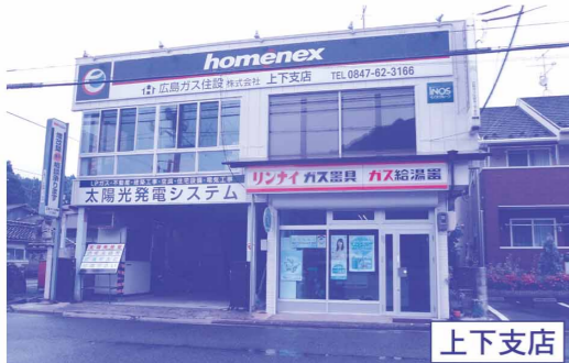
ガスセンター
